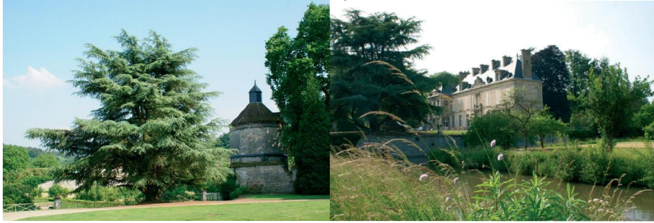
Le donjon, flanqué d'un somptueux cèdre, articule la cour du château avec l'accès au jardin en contre-bas.
